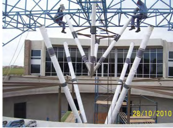
Montaje de las pirámides invertidas de mayor y menos diámetro respectivamente.
