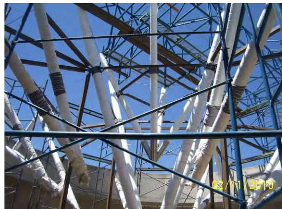
Montaje de los 8 triángulos perimetrales.
