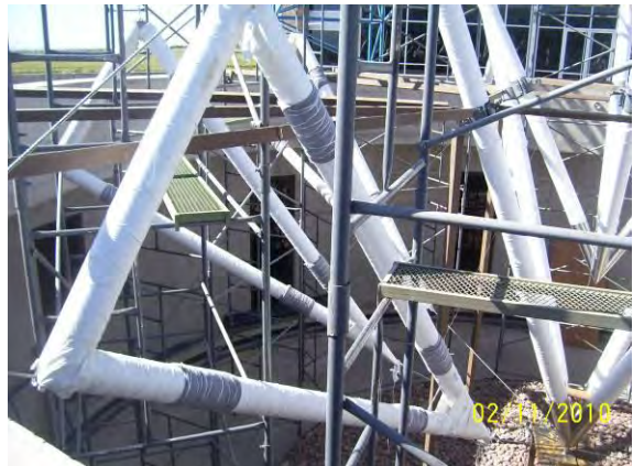
Montaje de las pirámides invertidas de mayor y menos diámetro respectivamente.
