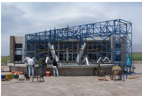
Puente grúa para el montaje del Diamante.
