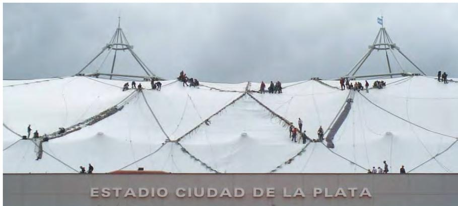
**Figura 9. Montaje de la cubierta de Estadio Ciudad de La Plata, 2011.**
