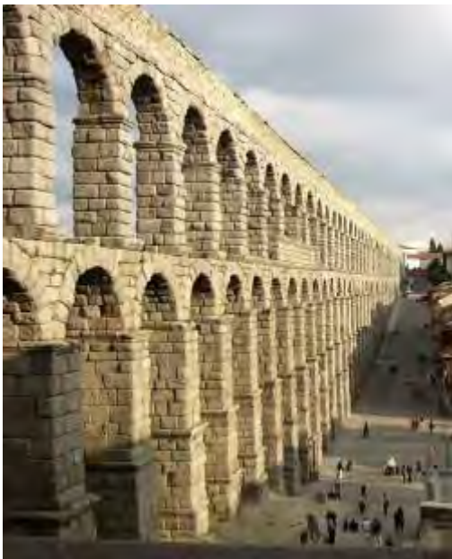
Fig.1: Aqueduto de Segovia – Seculos I e II tagem
