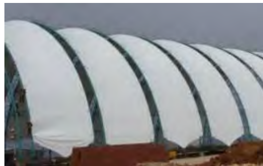
Fig.2: Moderna tensocobertura arqueada – em montagem
