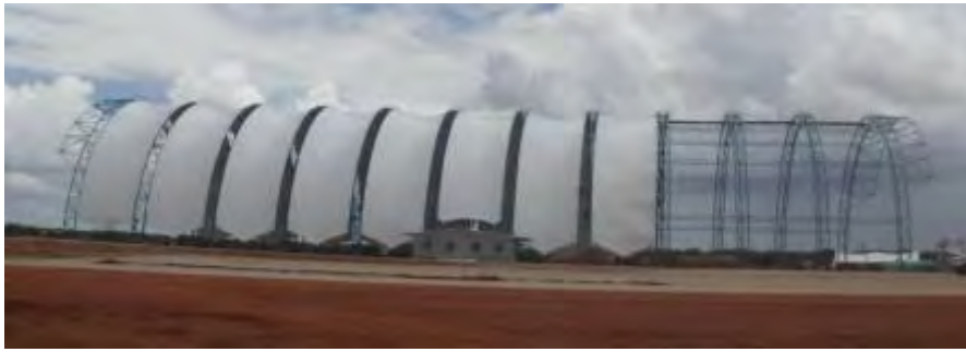
Fig. 15: Obra em andamento da montagem (TENSOR Estruturas Especiais e Tecnologia)
