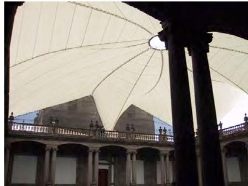
Fig. 2. “La Petatera.” Plaza de toros temporal con base en una estructura de madera recubierta con fibras textiles naturales denominados petates y cubierta en el patio central de Palacio de Minería, México.
