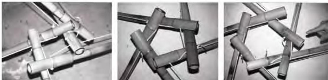
Figura 11 – Estrutura nodal do Domus *Tensegrity* (Ripper et al 2004)
