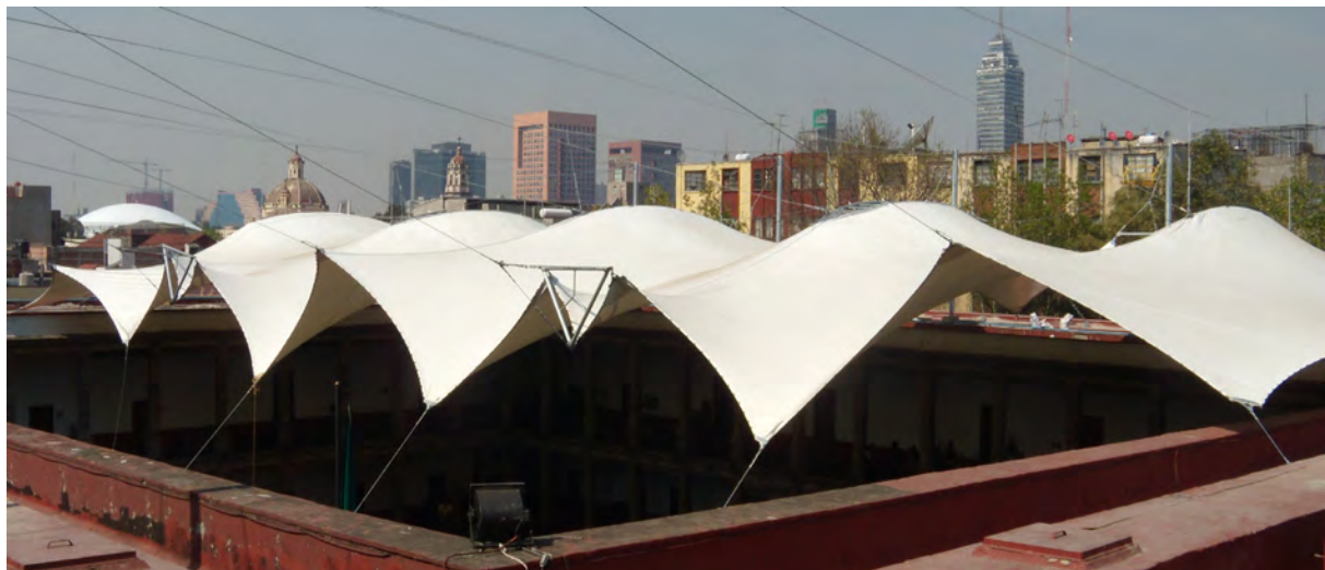
Figura 8. Estructura temporal que se utilizaba para cubrir el patio. Archivo INAH.
