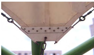
Esquinas solapadas o cerradas: (izquierda) los cables de borde están articulados y se pueden ajustar, (centro) no están articulados pero se pueden ajustar, (derecha) están articulados pero no se pueden ajustar.
