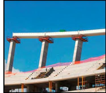
Fig. 36 Construcción de anillo perimetral
