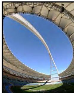
Fig. 32 Vista interior de arco, cables y membranas
