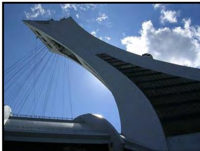
Fig. 13 Cables anclados a torre de 175 m.
