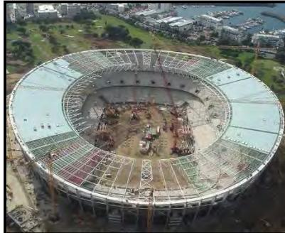
Fig. 35 Colocación de paneles de vidrio laminado
