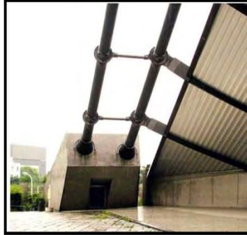
Figura 3. Cables de acero tensado
