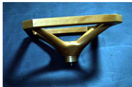
Fig. 19 – Quadripés de apoio dos vidros da cobertura
