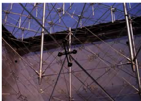
Fig. 26 – Detalhe do cubo virtual e da estrela de aço que une as placas de vidro do lustre
