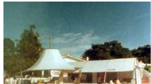
Fig.6 Cubiertas Nelson Fiedler.
