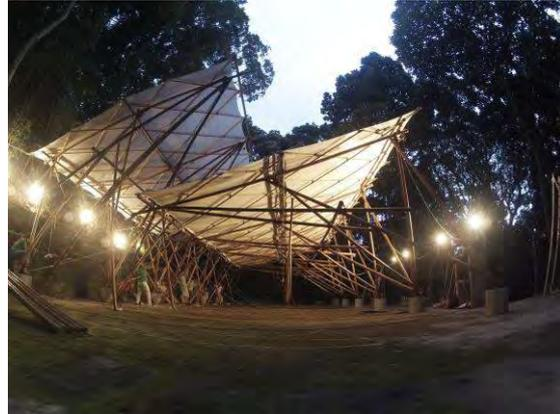
Figuras 31 e 32 – Elevação do setor 2 pesando 950kg empregando pórticos treliçados e sistema de elevação com roldanas e cabos acoplado ao setor 1.
