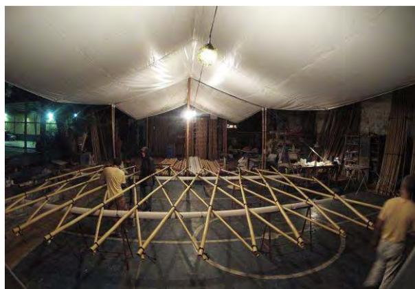
Figuras 13 e 14 – Fabricação de módulo de casca reticulada utilizando ligações amarradas.
