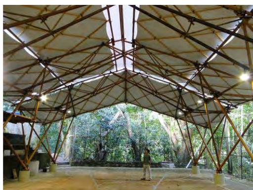
Figura 40 – Vista interna do Galpão com largura de 15 metros e vão livre de 10 metros.
