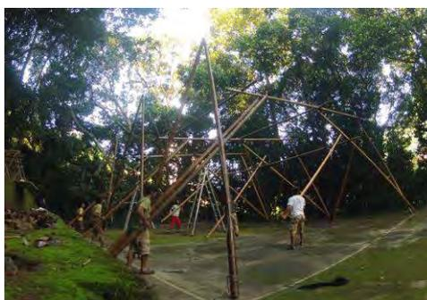
Figuras 11 e 12: Montagem e elevação do protótipo da Nave principal em 2 módulos: setor 1 sendo erguido utilizando sistema de elevadores com cabos a partir de pórticos de bambus e roldanas.
