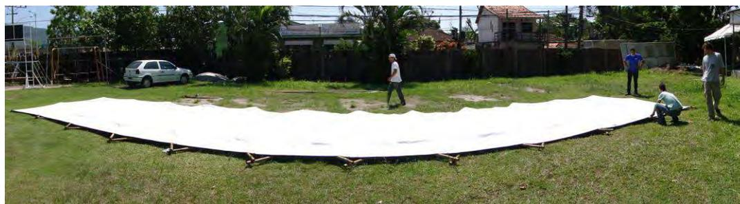
Figura 15: Ensaio de montagem da casca reticulada com a lona têxtil modelada para verificação e ajuste das medidas definitivas de fabricação.
