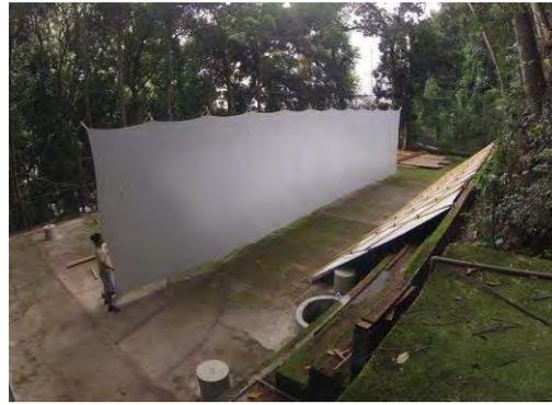
Figura 25 – Início da montagem da estrutura a partir das cascas reticuladas pantográficas armadas no solo.
