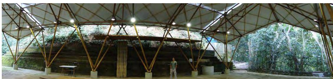
Figura 39 – Cobertura de 345 m<sup>2</sup> (23 x 15m) e vão livre de 230 m<sup>2</sup> (23 x 10 m): vãos de 4 metros entre as sapatas no sentido longitudinal e vão livre de 10 metros no sentido transversal.
