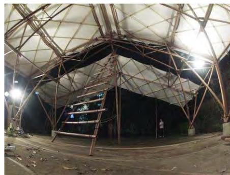
Figura 37 – Montagem da casca treliçada pantográfica no solo para cobertura dos alpendres.
