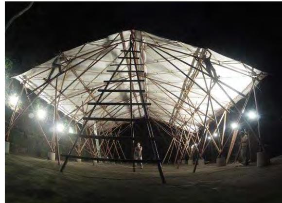
Figura 33 – O setor 2 é pré-escorado e com a ajuda de um andaime móvel em bambu desacopla-se o sistema de elevadores para a continuidade da elevação.
