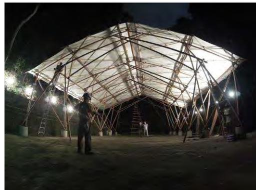
Figuras 35 e 36 – Rotulação dos banzos inferiores dos pórticos para o seu posicionamento definitivo e fixação das treliças espaciais.
