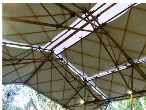
Figura 41 – Detalhe da treliça espacial, da casca reticulada e do teto em lona têxtil tensionada.
