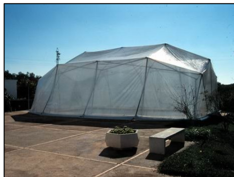
Figura.- 1, 2: Proyecto cubierta desplegable de aspas para cubrir una piscina unifamiliar 11 x 7 m. Sevilla, Dr. Félix Escrig, la aplicación de estructura transformables cambia drásticamente el paisaje urbano, ayudando a dar más de una función el espacio arquitectónico. Fuente: Performace. SL, 2013).
